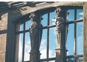
Fenster am Henneberger Haus
