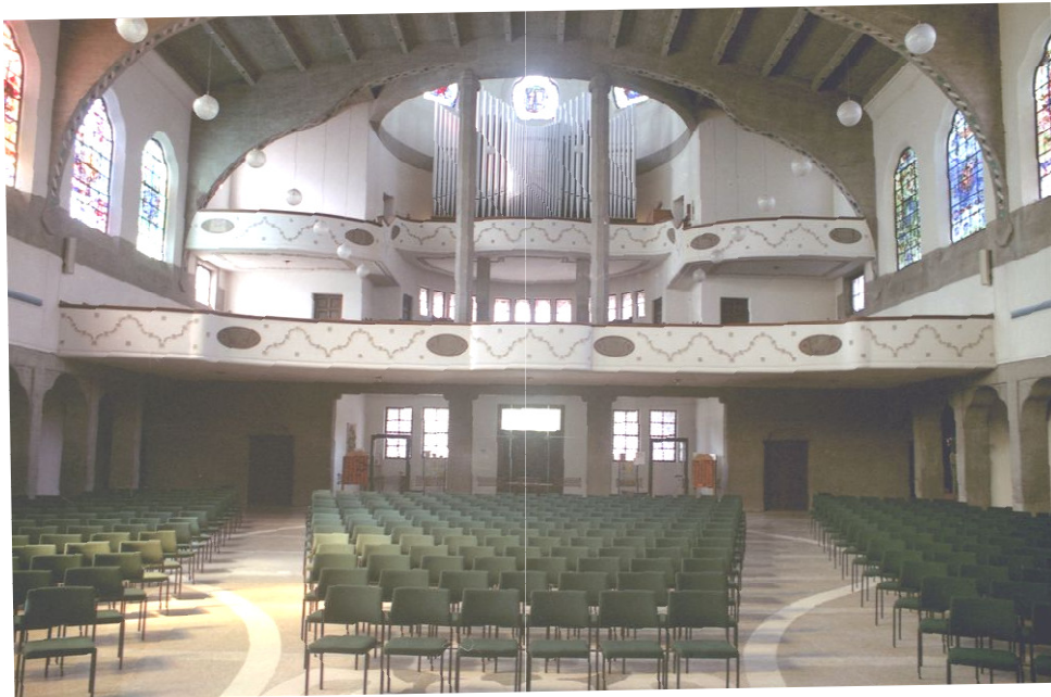
Blick vom Chorpodest auf die Kirche, hier noch ohne inzwischen eingezogene Glaswand Foto: H. Stadelmann
